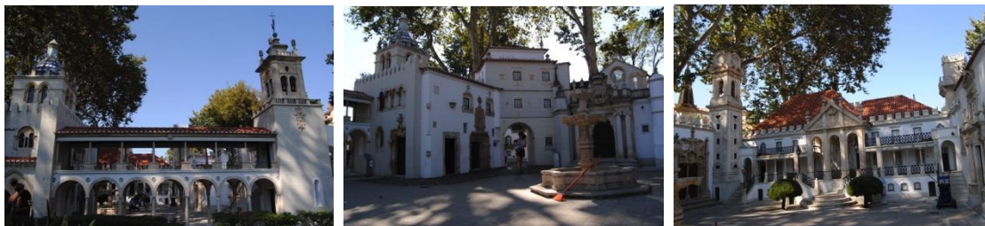
Imagens 5 a 7: Vistas do pátio interno da Casa de Coimbra
