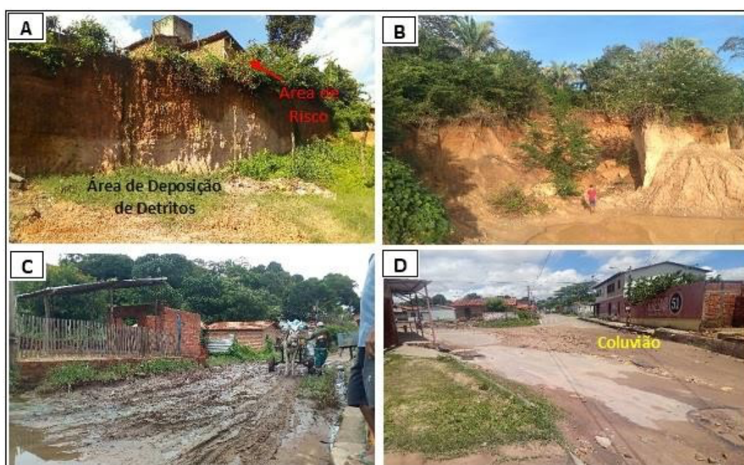
Figura 6 – Feições Tecnogênicas e Movimentos gravitacionais de massa em Teresina, Piauí. Em A, Corte de relevo e erosão progressiva de talude de corte com movimentação de massa (coordenadas 5°2'53.91" S e 42°45'52.34" W). Em B, Cortes de relevo com alto nível de degradação da paisagem e movimentação de massa (coordenadas 4°59'53.26" S e 42°45'31.53" W). Em C, formação de Depósitos Coluviais no sopé de um morro residual (coordenadas 5°2'19.40" S e 42°44'41.45" W). Em D, formação de coluvião nas coordenadas 5°2'53.88" S e 42°45'30.25" W.
