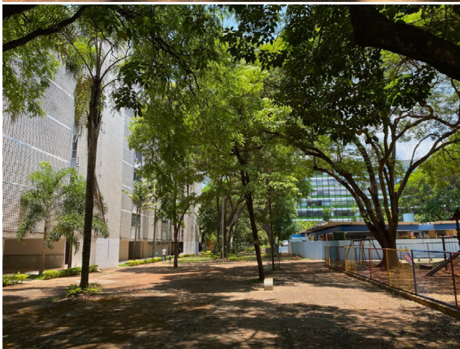
Figura 3 — Fundos de um prédio da quadra 300.
