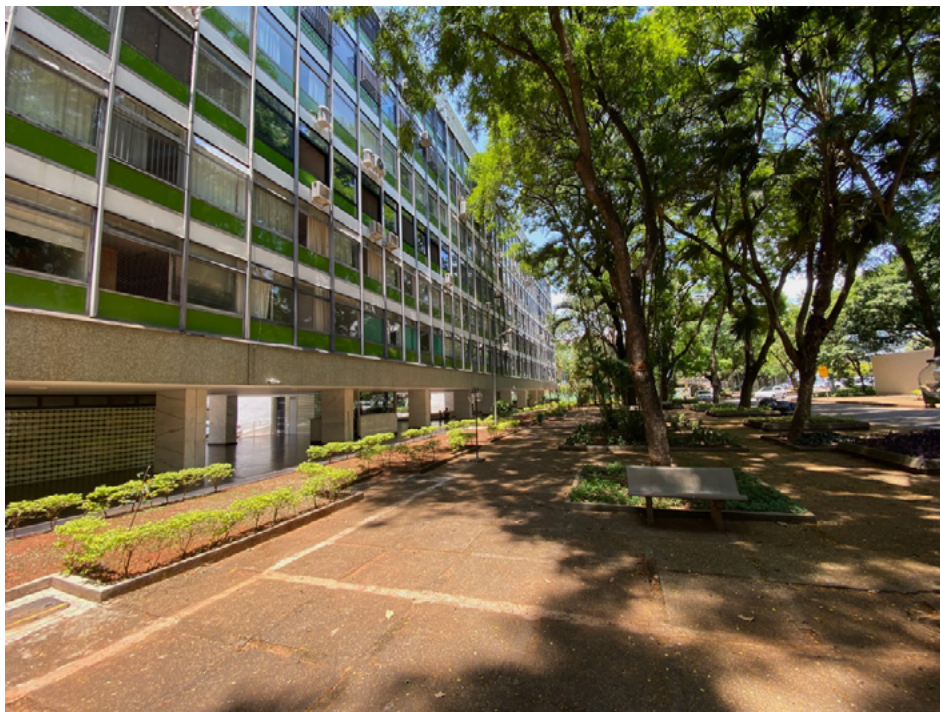
Figura 2 — Um prédio da quadra 300.
