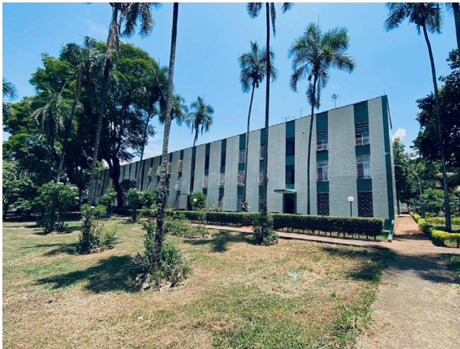
Figura 4 — Um prédio da quadra 400.
