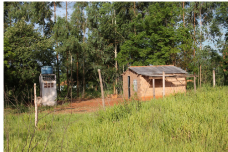
FIGURE 14 (left) – Casas de alvenaria, com teto em fibrocimento, construídas pelos indígenas. Jaguapire, 11/2018.
